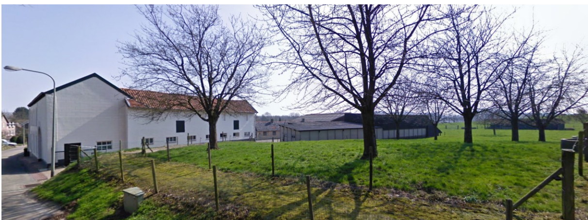
Figuur 3a: Bebouwing in het plangebied gezien vanaf de zuidelijke richting. 3 Links de straatzijde, rechts de achterzijde met opstellen en het erf.
