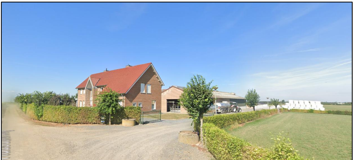
Afbeelding 4: aanzicht bedrijf vanuit zuidoostelijke zijde.
