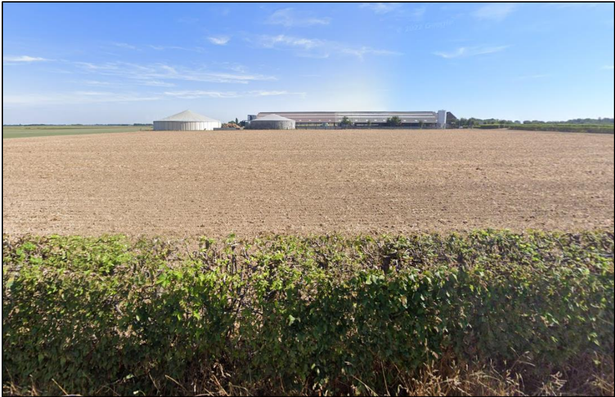
Zicht vanuit Lintjensweg. De bestaande bebouwing is hier duidelijk zichtbaar, waarbij de grootste mestsilo ook het meest beeldbepalend is. De nieuwe stal komt vrijwel volledig achter deze mestsilo te liggen.
