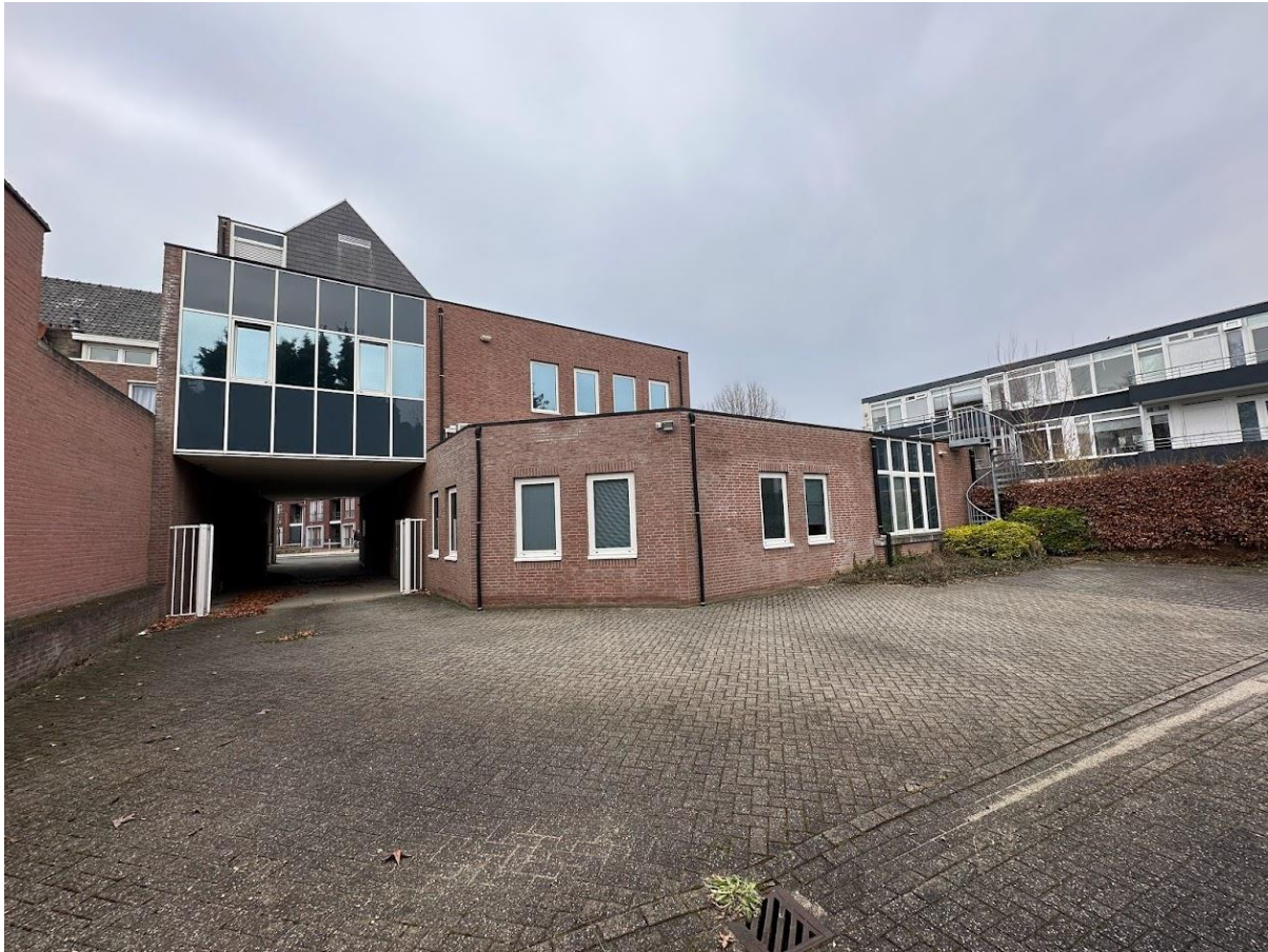
Figuur 4: Bestaande bebouwing Stationstraat 171 (achterzijde), doorgang naar Stationstraat is goed te zien.
