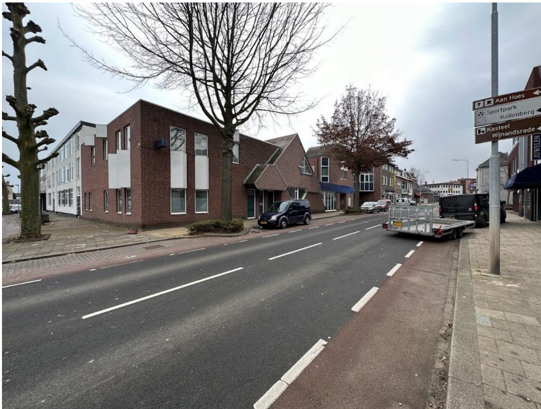
Figuur 3: Bestaand kantoorgebouw Stationstraat 171
