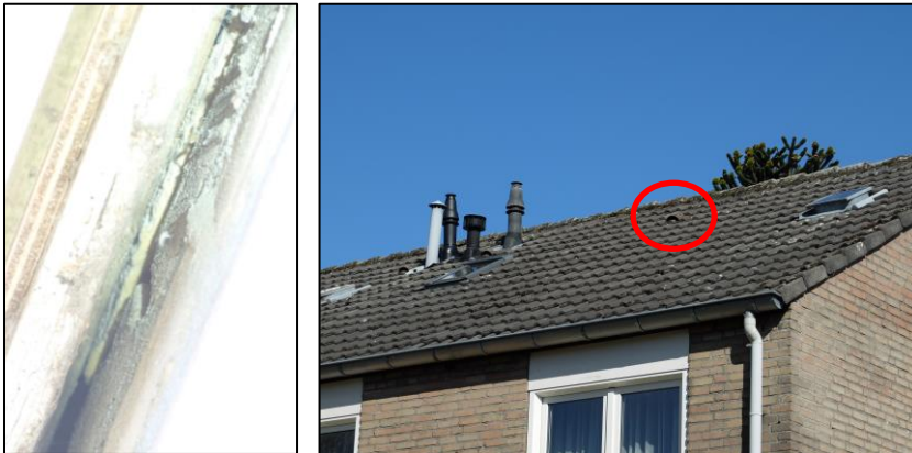
Figuur 8 Links: Openingen tot de spouw onder de dak betimmering; Rechts: Ventilatie pannen en gevelpannen
