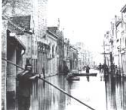
Overstroming in de Vugterstraat, gezien vanaf de Vugterpoort
