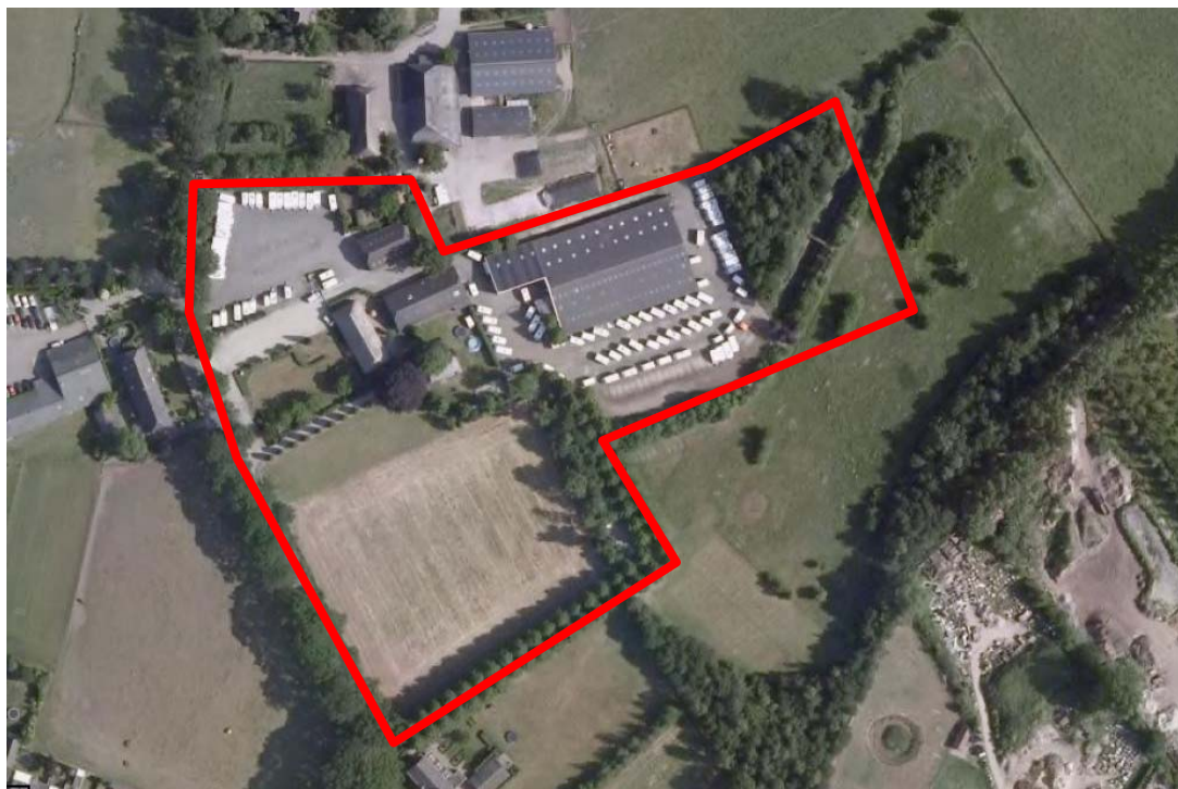
Luchtfoto van het plangebied
