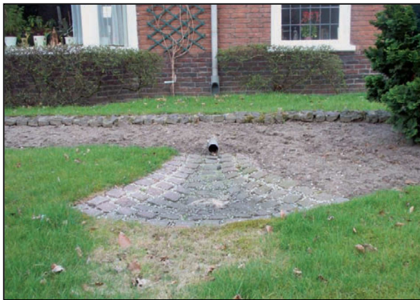
Figuur 15. Voorbeeld van een infiltratieveld.
