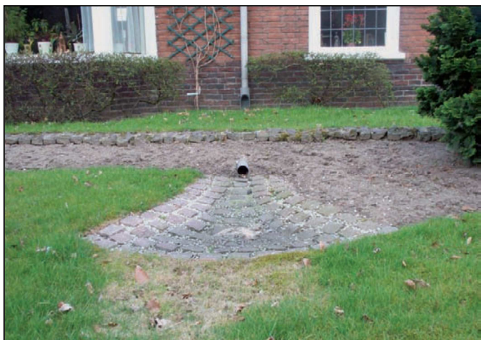
Figuur 15. Voorbeeld van een infiltratieveld.
