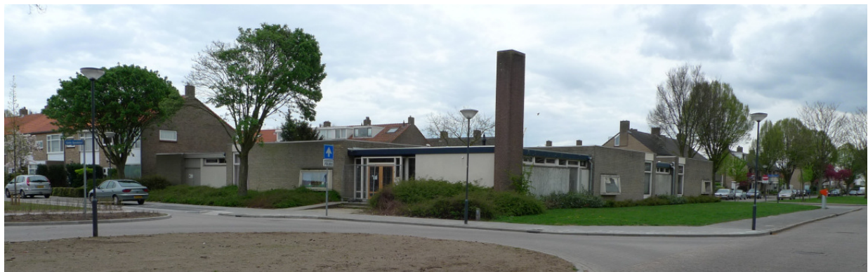
2.h Bestaande bebouwing: eenlaagse school
