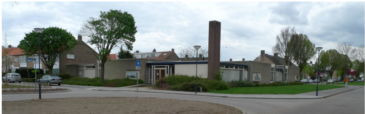
2.h Bestaande bebouwing: eenlaagse school
