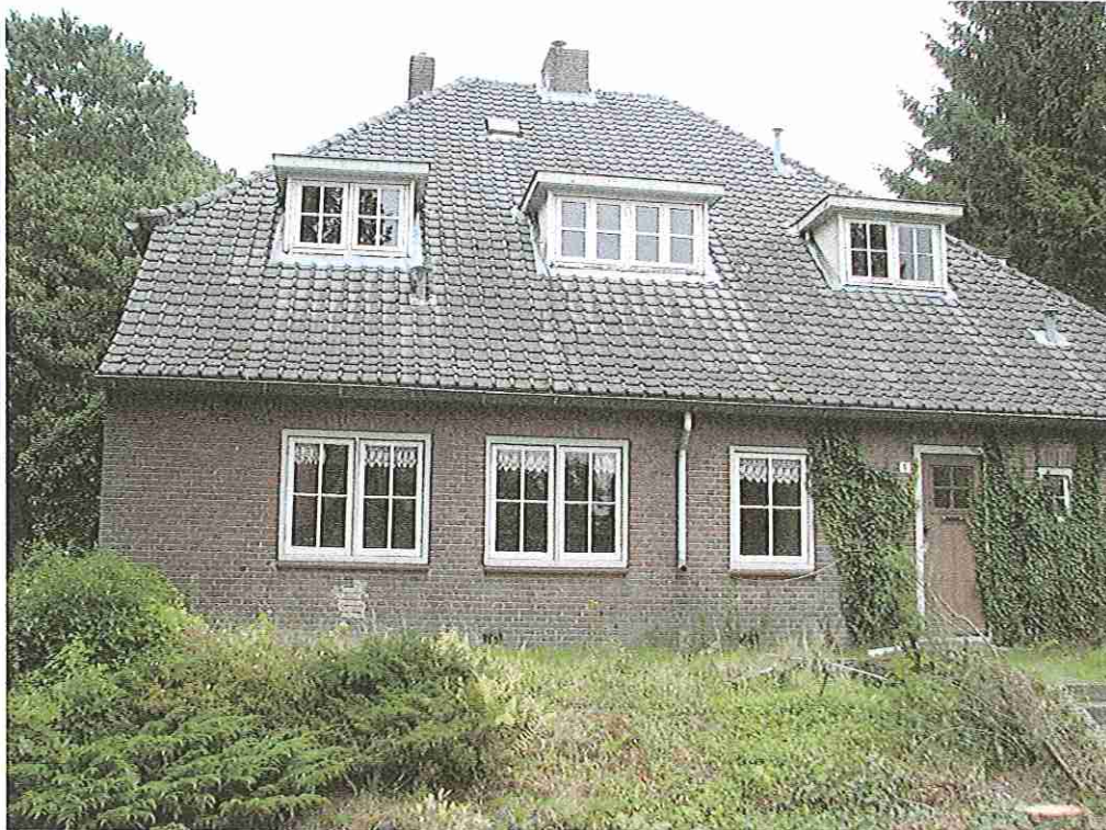
Foto 1 Zicht op het westelijke deel van de planlocatie: te slopen villa.
