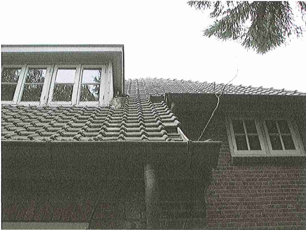
Foto 3 Zicht op dakdelen waar ruimten aanwezig zijn die potentieel door vleermuizen als verblijfplaats kunnen worden gebruikt
