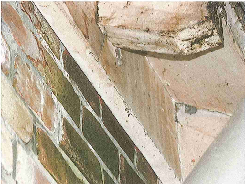
Foto 4 Zicht op onderzijde dakdelen waar ruimten aanwezig zijn die potentieel door vleermuizen als toegang tot verblijfplaats kunnen worden gebruikt
