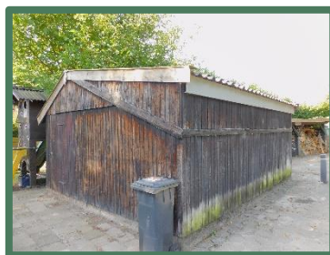
Voorzijde te slopen schuur
