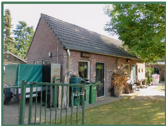
Achterzijde te behouden garage
