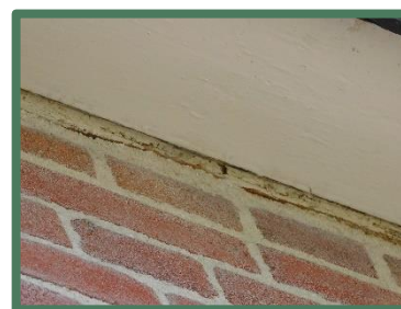
betimmering onder goot
