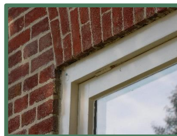
aangesloten inbouw kozijn
