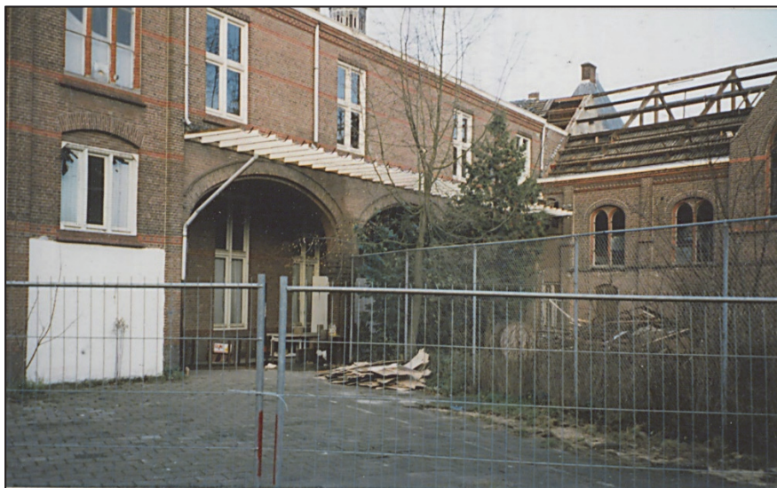
Afb. 3.4.2. – Sloop- en verbouwwerkzaamheden in 1994. (Foto V. Delleman-De Kort, collectie BHIC, nr. 1923-001297, d.d. 20-12-1994)
