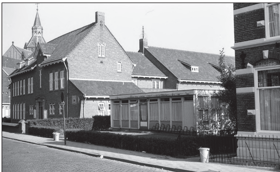
Afb. 3.4.3. – De situatie nabij het pand Rozenoord. Ter plaatse van de laagbouw ligt nu de Secretaris van Rooijstraat (Foto V. Delleman-De Kort, collectie BHIC, nr. 1923-004340, d.d. 20-12-1994)
