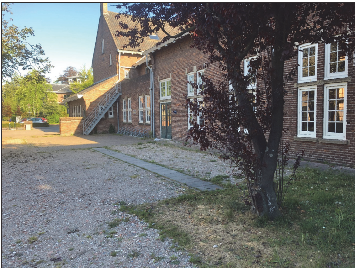
Afb. 3.2.2.1. – Eén zijde van het gebouw. Een detectieverstorende factor is bijvoorbeeld de boom, het verhardingspuin, de metalen trap en het gebouw zelf.
