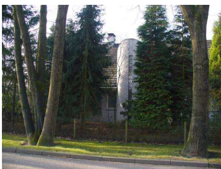
Aanzicht bestaande woning vanaf Zonneweilaan
