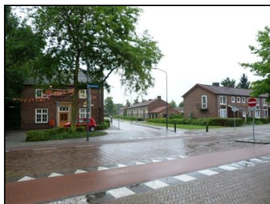
Figuur 4. Noordelijk deel onderzoekslocatie, Esschestraat.
