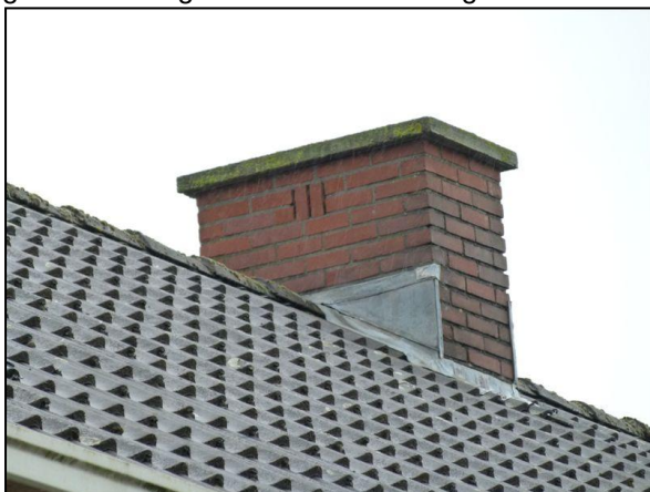
Figuur 13. Openingen schoorsteen.
