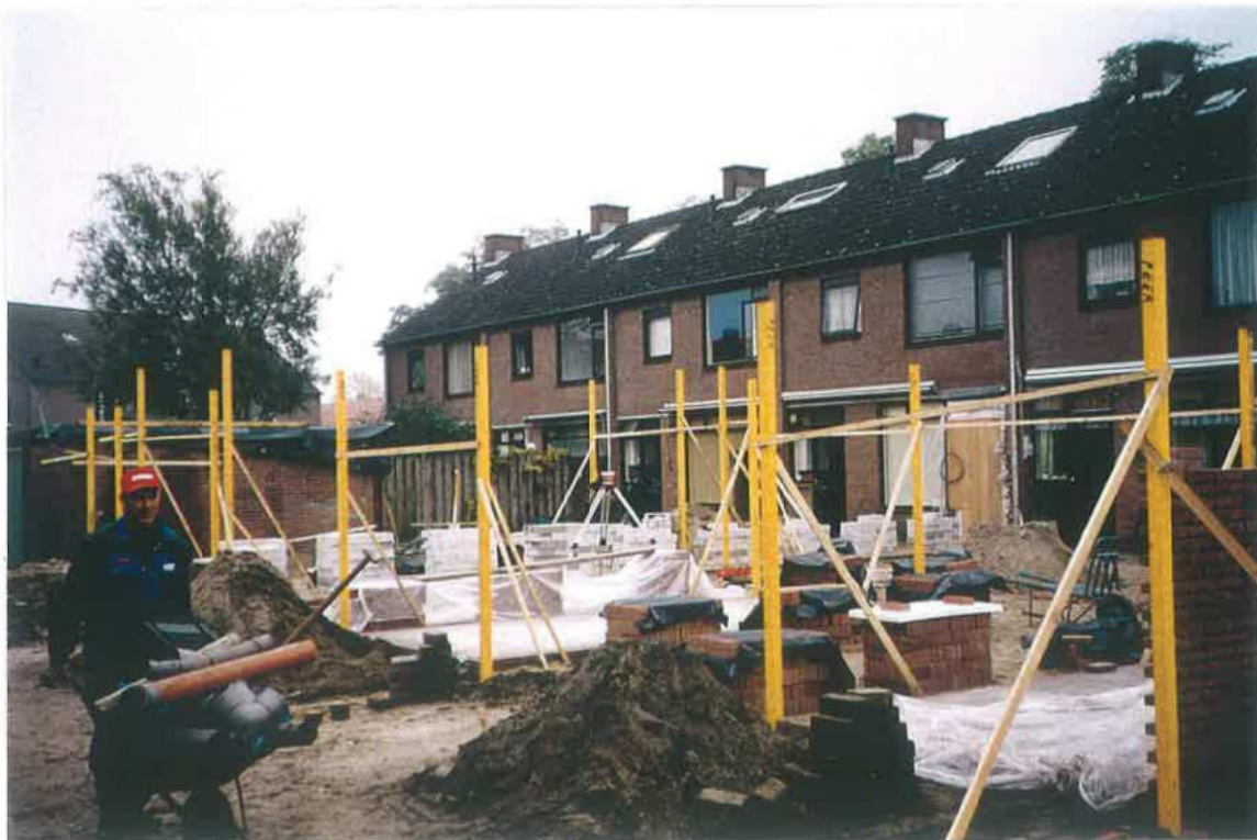
Herstel en bouw schuurtjes achtertuinen Maarten Trompstraat 5 t/m 11
