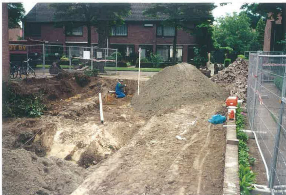
Ontgraven cunet PTT-kabels Maarten Trompstraat
