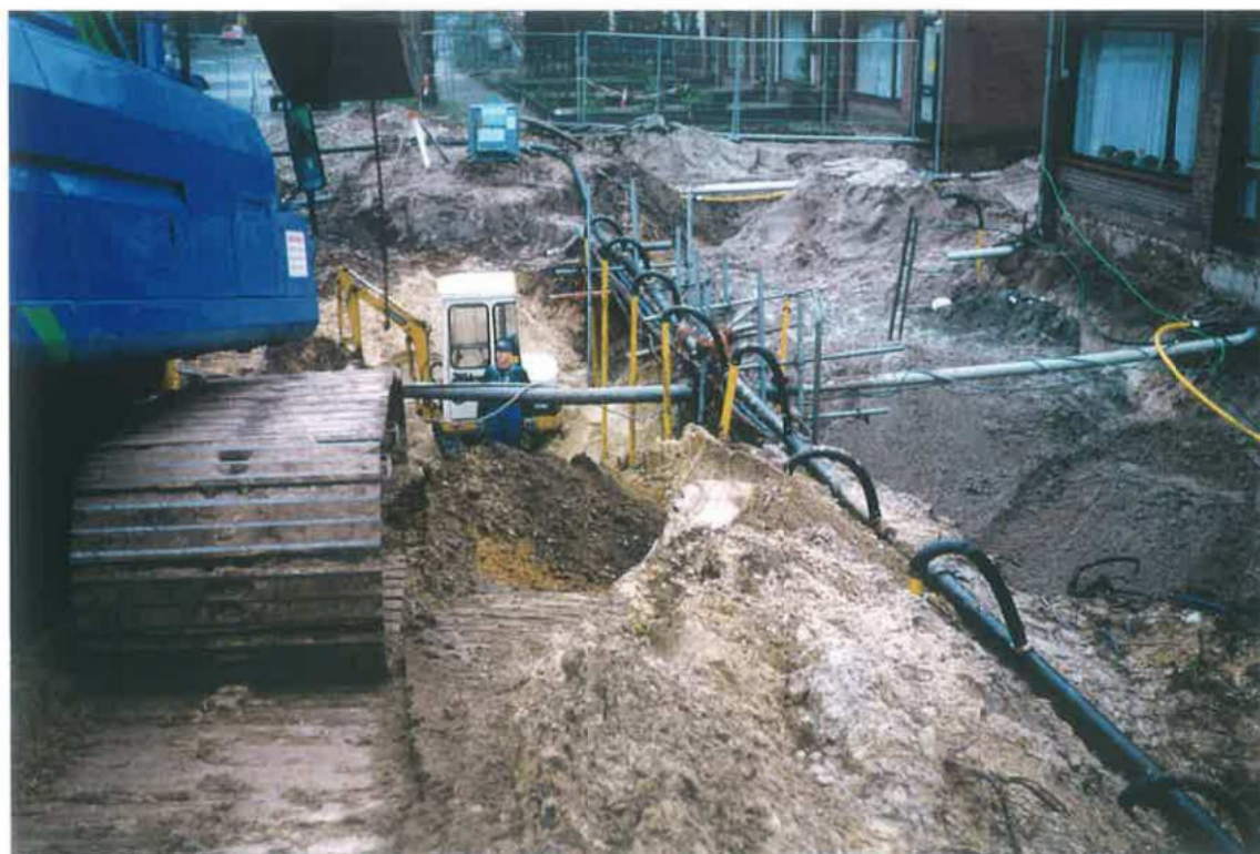
Bronbemaling tbv grondontgraving ter plaatse van de voortuinen Maarten Trompstraat 14 t/m 20
