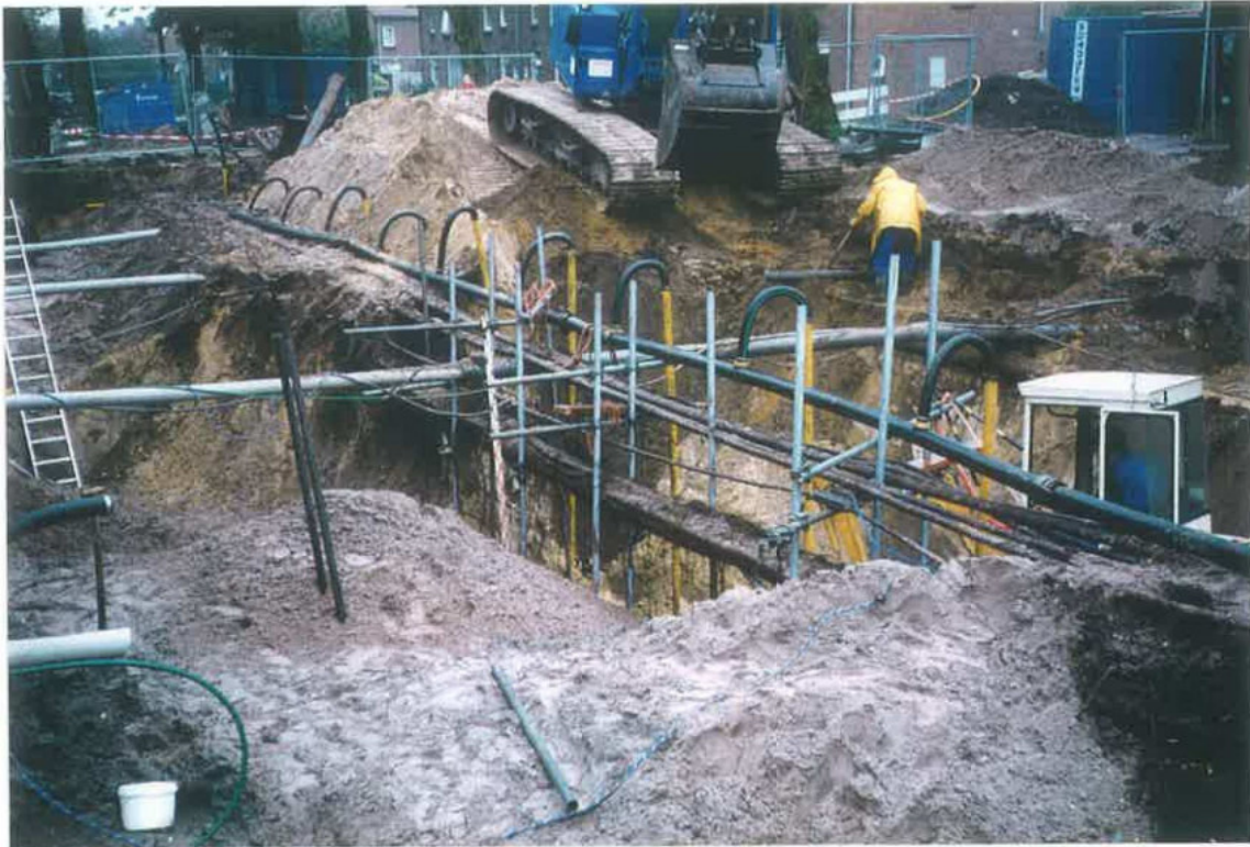
Bronbemaling tbv grondsanering ter plaatse van de voortuinen Maarten Trompstraat 14 t/m 20
