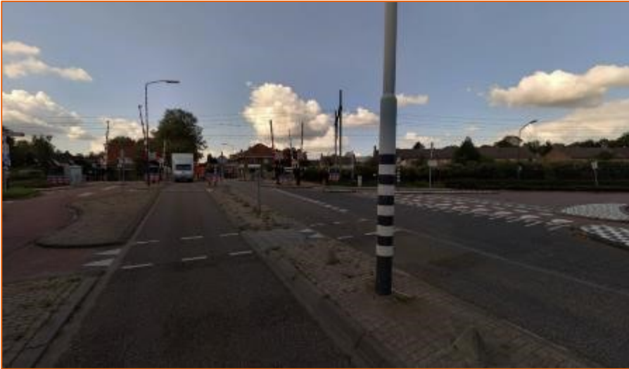
Figuur 14; Te smalle opstelruimte voor fietsers in de middenberm op de kruispunten aan weerszijde van de spoorkruising
