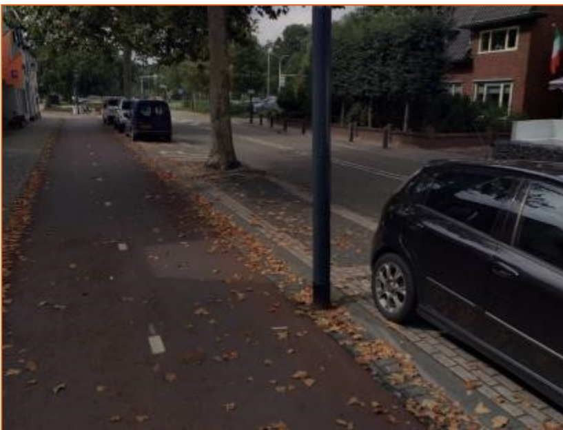
Figuur 12; ontbreken van de benodigde objectvreesafstand door het plaatsen van verlichting direct naast het fietspad
