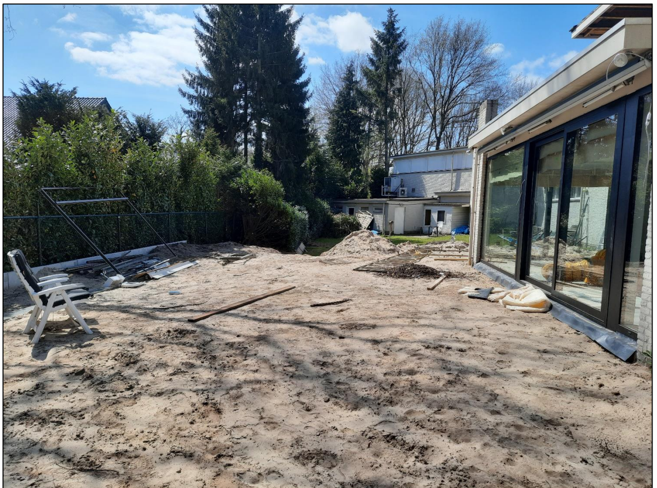
Figuur 4: Foto van het zuidelijk deel van het plangebied, kijkende in zuidwestelijke richting. (Foto: 22 april 2021).
