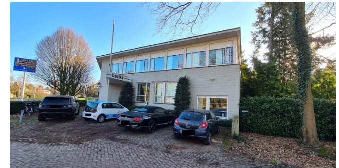
Figuur 5: Te slopen pand gezien vanaf Hoevenessestraat
