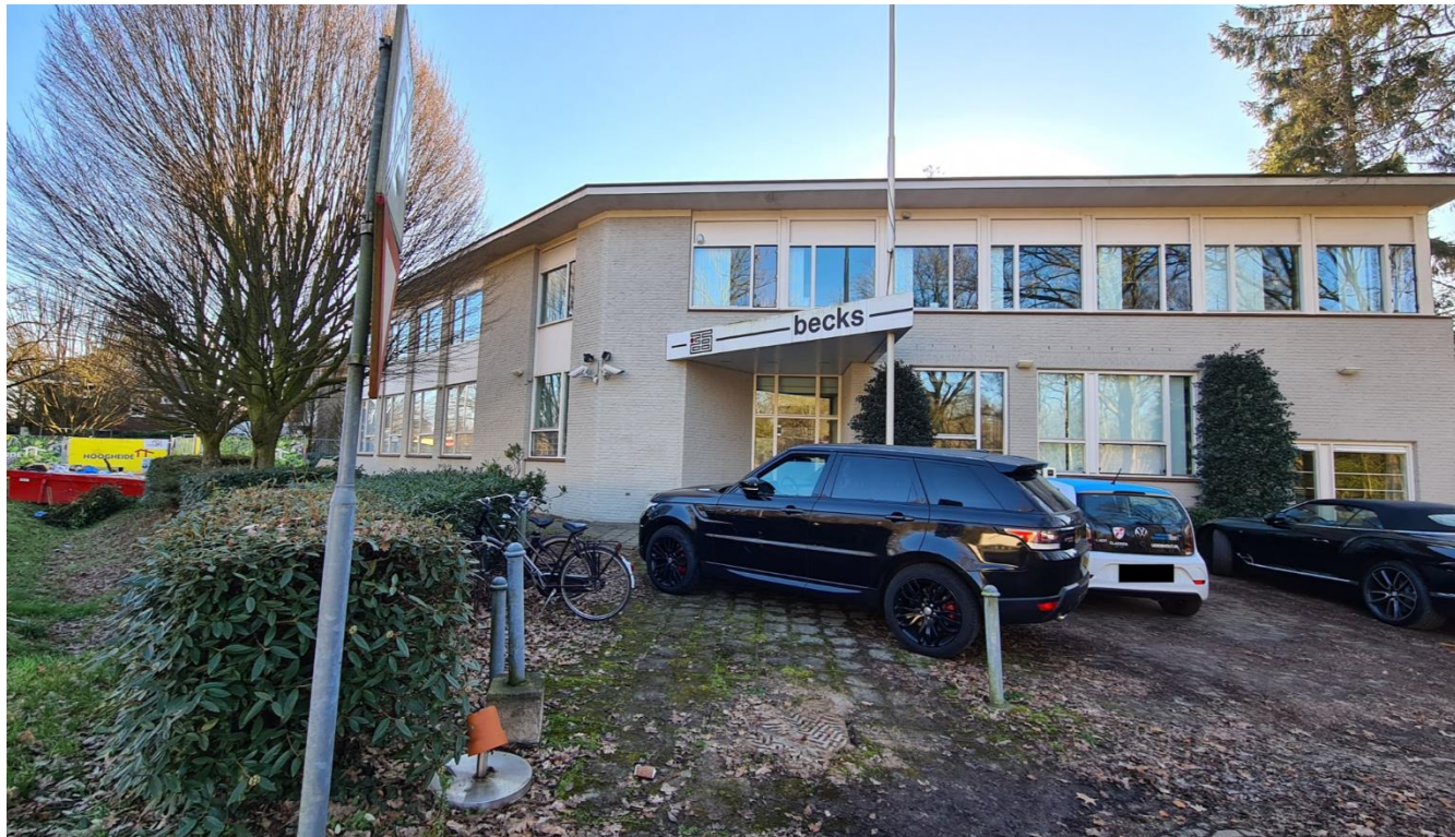
Figuur 4: Te slopen pand op hoek van Helvoirtseweg en Hoevenessestraat
