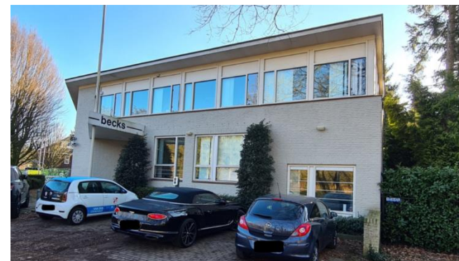
Figuur 2: Westgevel van het kantoorpand
