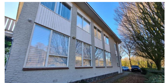
Figuur 9: Gevel te slopen pand aan Helvoirtseweg
