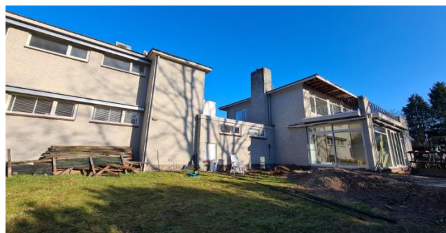
Figuur 8: Achterkant te slopen en gedeelte te renoveren pand gezien vanaf de binnen tuin
