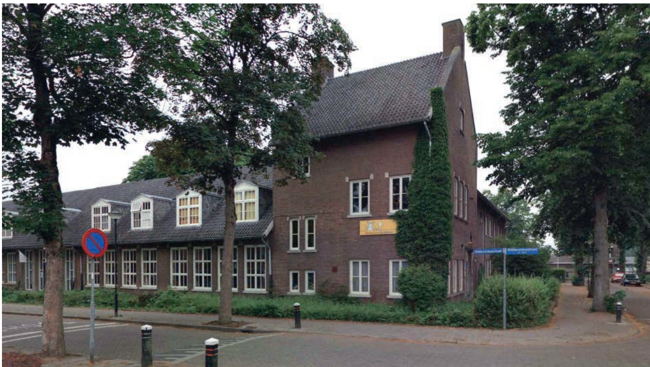
In te passen gebouw: de Willibrordusschool vanaf de Antoniusstraat
