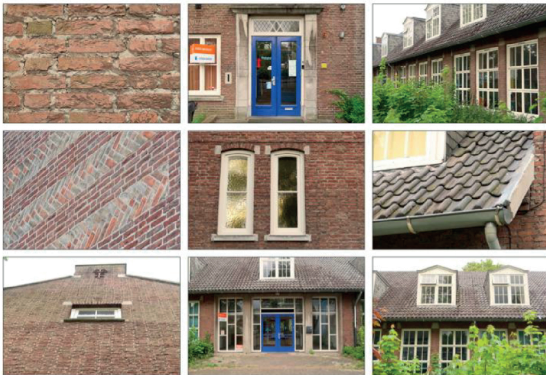
Willibrordusschool: details karakteristiek metselwerk.
