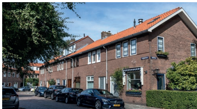
Ambachtelijke details, rollagen en sierboven in het metselwerk
