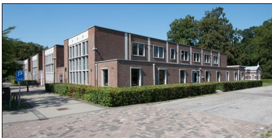
Afb. 2.23 Technisch gebouw, 'De Weverij', vermoedelijk gebouwd in 1956 (BHIC archief 1473, inv. Nr. 3259).
