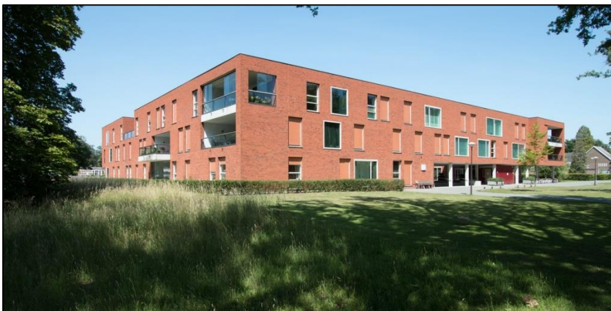
Afb. 2.30 Nieuwbouw Vijverhof uit 2012 op de plaats van het in 1995 gesloopte hoofdgebouw. Architectonisch zeker niet onaardig, doch enkel in oriëntatie verweven in de omgeving.
