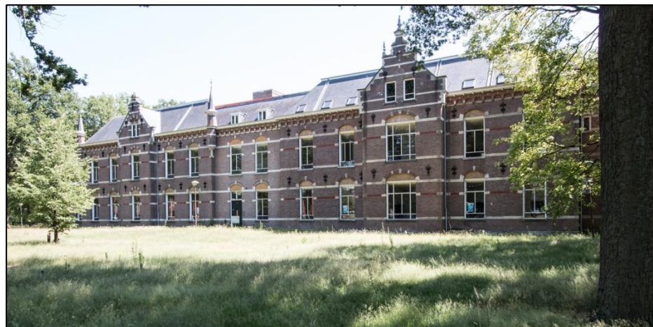
Afb. 2.14 Door het historiserende karakter van het tussenlid van het Sint Jozefhuis is een eigenaardig aandoend, langgerekt gebouw ontstaan, versterkt door het arkeltorentje van de oudbouw uit 1894.
