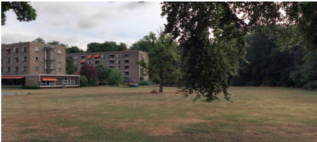
Plangebied gezien vanaf de Loyolalaan met links het verzorgingstehuis en rechts een deel van het Loyolapark (Globespotter 2017)
