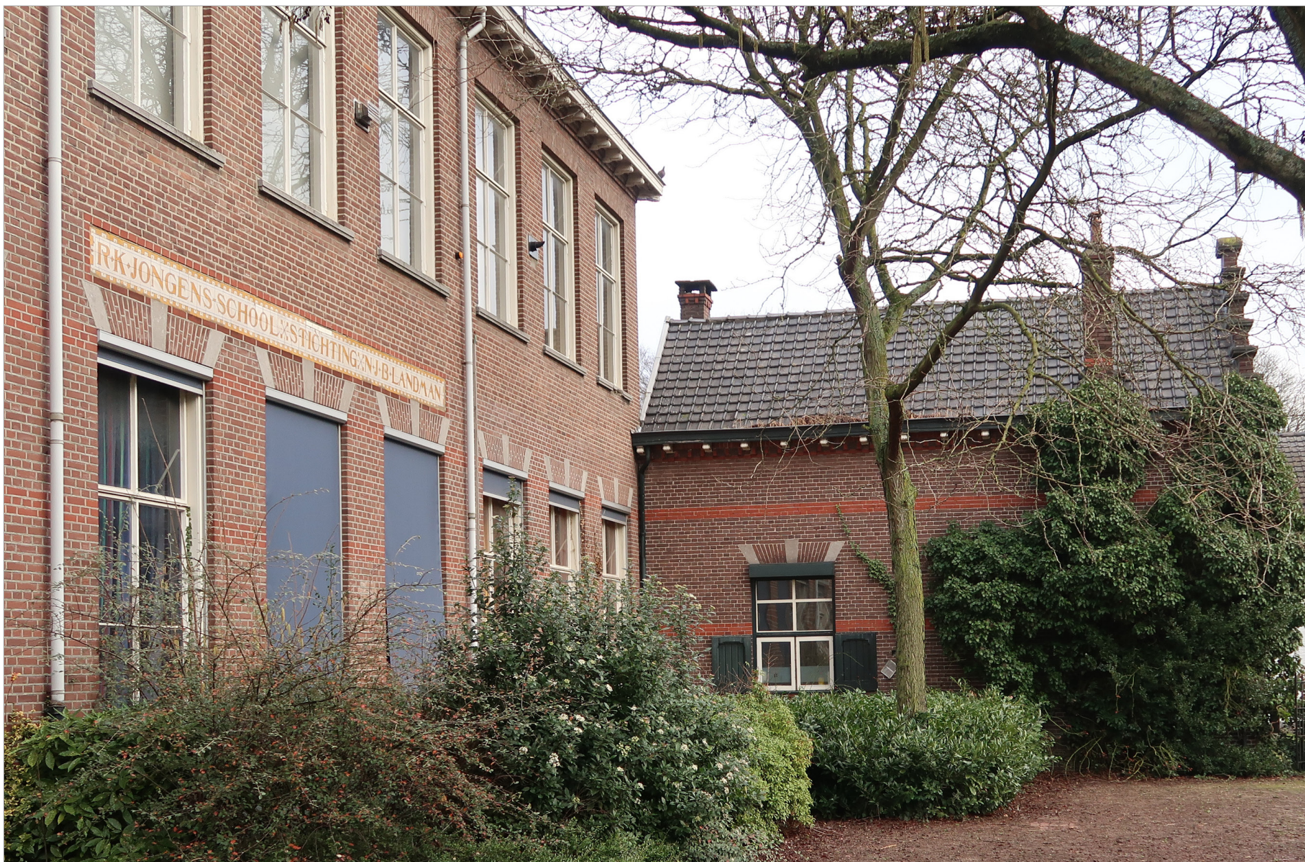
De voormalige schoolmeesterswoning schermt de oostelijke flank af van de voormalige speelplaats op het voorterrein van het schoolgebouw. De westelijke flank werd afgeschermd door een houten veranda met bakstenen poort (verwijderd, zie foto's pagina 8).
