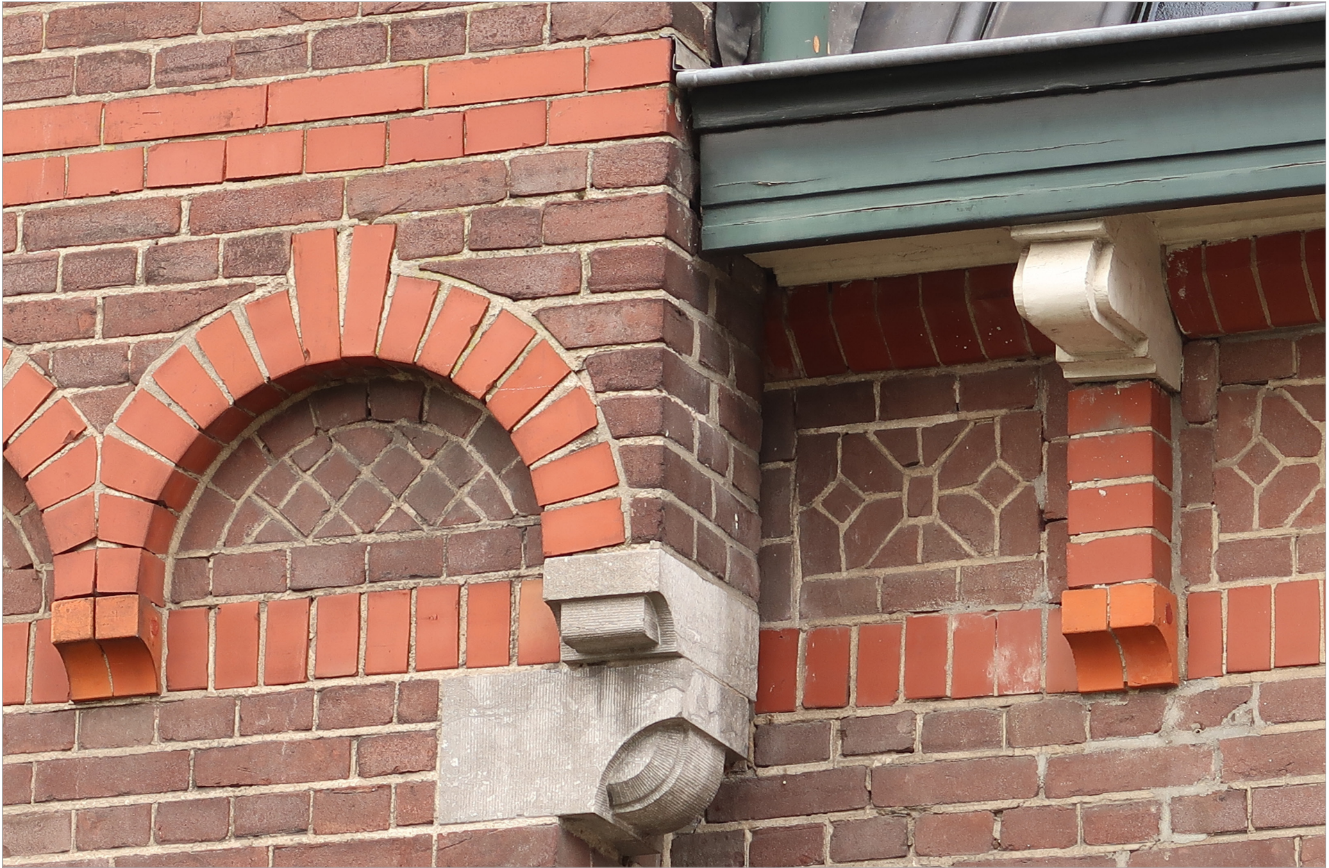
Detail van de voorgevel van het woonhuis: rijk kleur- en materiaalgebruik met een consequent doorgevoerde ornamentering bij de hardstenen kraagsteen en de houten gootklos.
