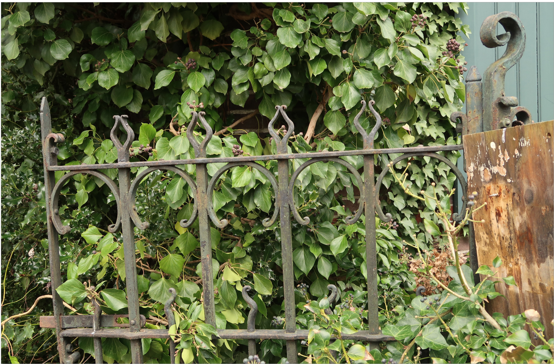
Restant van het oorspronkelijke smeedijzeren hekwerk, geplaatst op de scheiding tussen de voortuinen van de schoolmeesterswoning en de school, en thans vrijwel volledig overwoekerd.
