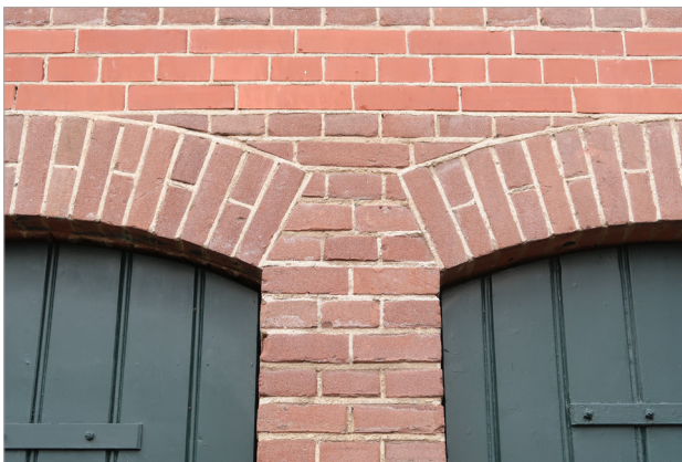
Details en materialen: bakgoot op klossen (b), metselwerk, dorpel, venster (m), speklag, segmentboog, kraaldelen (o).
