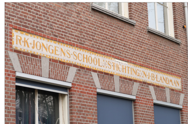
Voorgevel school: overzicht, entree en tegeltableau.
