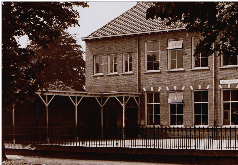
Boven: klassenfoto's van vóór 1954 waarop de oorspronkelijke indeling van de onderramen en de bovenlichten is te zien (bron: archief Heemkundekring De Kleine Meijerij). Onder: links de situatie na het aanbrengen van de stalen ramen en vóór het verwijderen van de veranda en het smeedijzeren hekwerk in 1981 (bron: archief Heemkundekring De Kleine Meijerij), en rechts de voormalige schoolmeesterswoning in 1986 (bron: beeldbank BHIC).
