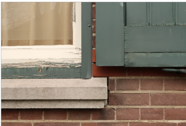
Geveldetails: dakkapel, bakgoot op consoles (b), rondboogfries met siermetselwerk (m), venster, luik en dorpel (o)
