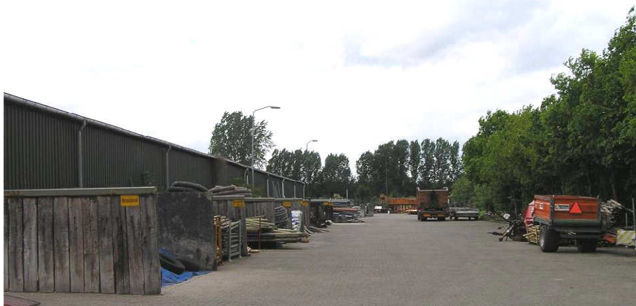
Fig. 6a Zicht op de robuuste groenstrook (volgroeide beplanting, > 10 m) vanaf het terrein aan de Achter- straat (noordelijk deel) + zicht op locatie nieuwe loods (achter bestaande loods)
