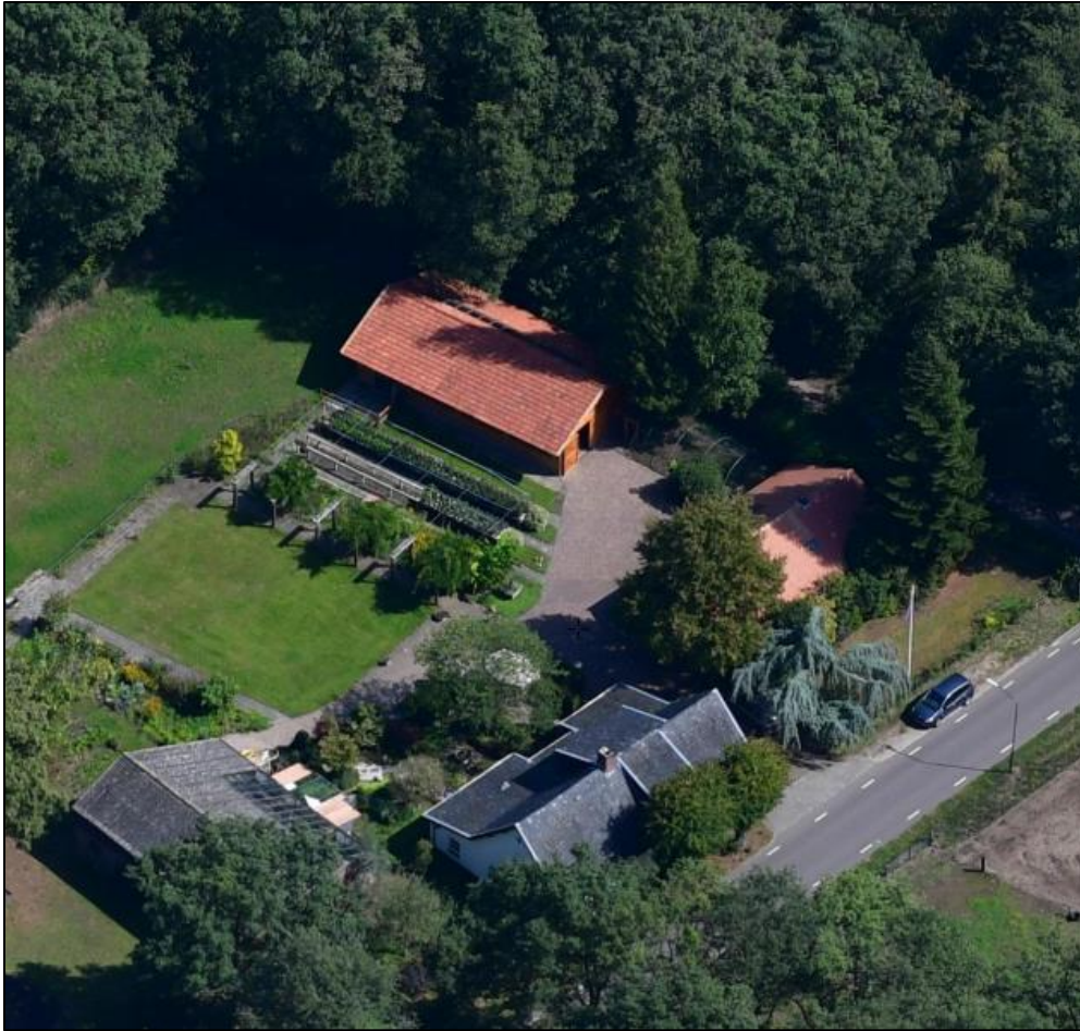
Afbeelding 4: Luchtfoto planlocatie Loverensestraat 2, Cromvoirt vanuit noordwestelijke richting.
