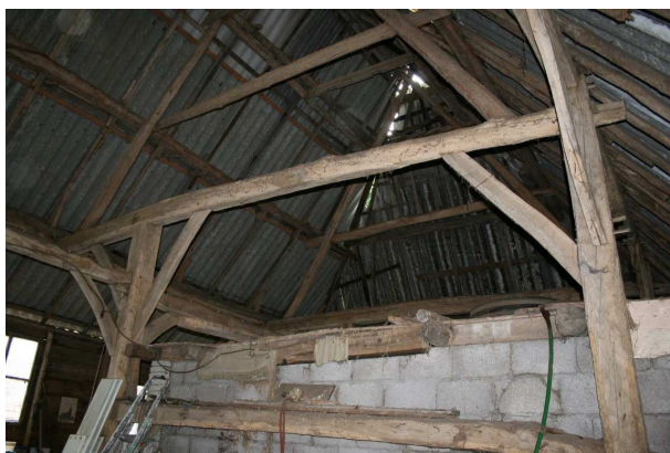
Gebint met dekbalk (links), ankerbalk (rechts) en een tweede laag geplaatste ankerbalk
