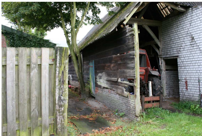
Voorgevel vanaf de rechterzijde
