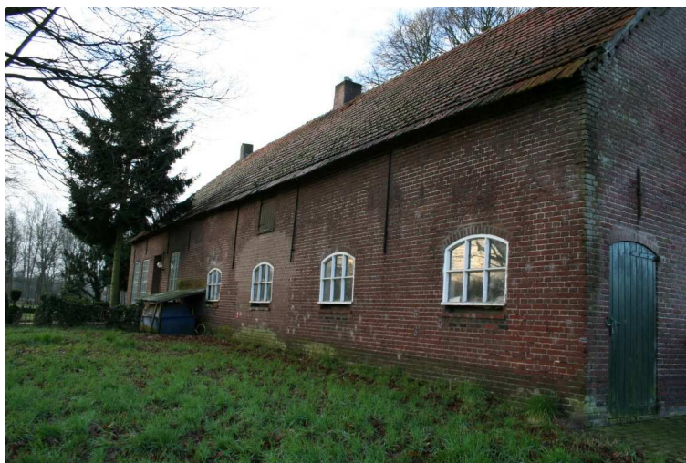
Voorgevel vanaf de rechterzijde
