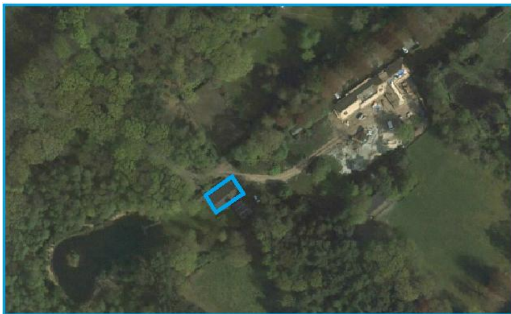
Figuur. Bijgebouw (blauw omkaderd) gesitueerd achter woonhuis
