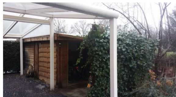
G/H/E Bijgebouw en overkapping
