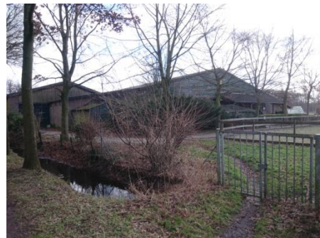
Paardenstallen die gesloopt gaan worden
