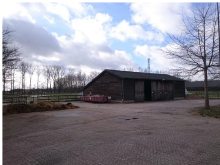
Houten schuur die gesloopt gaat worden
