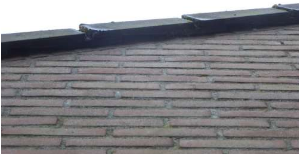
Figuur 6. Onder de dakpannen van deze twee gebouwen zijn ruimten die door vleermuizen gebruikt kunnen worden. Uit het onderzoek is gebleken dat dit niet het geval was.
