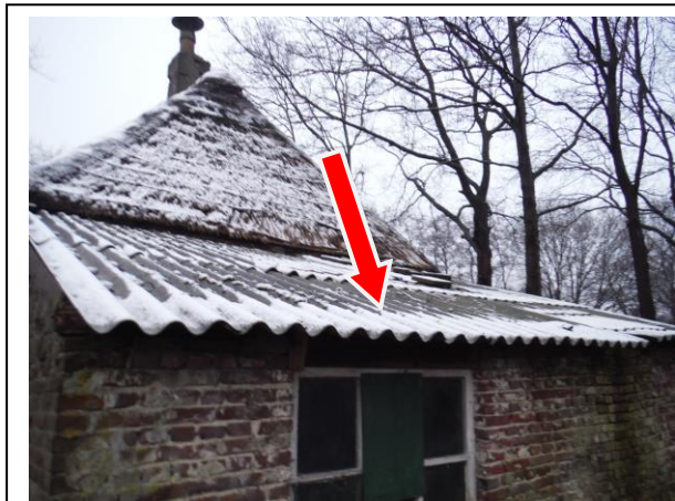
Foto 1: M1: Golfplaten, dakbeplating
