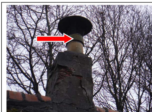
Foto 5: M5: Dakhoed, hulpstuk
