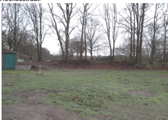
Ter hoogte van het plangebied is de Cromvoirtse Dijk deels verzakt en ontbreekt onderbeplanting.
