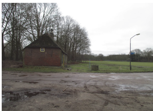
Het monumentale pand staat vlak aan de weg en tegen de dijk aan.
