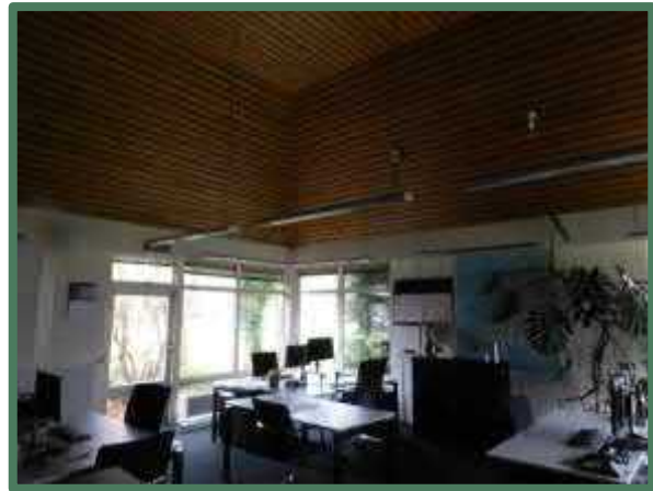
Binnenzijde te slopen kantoor
