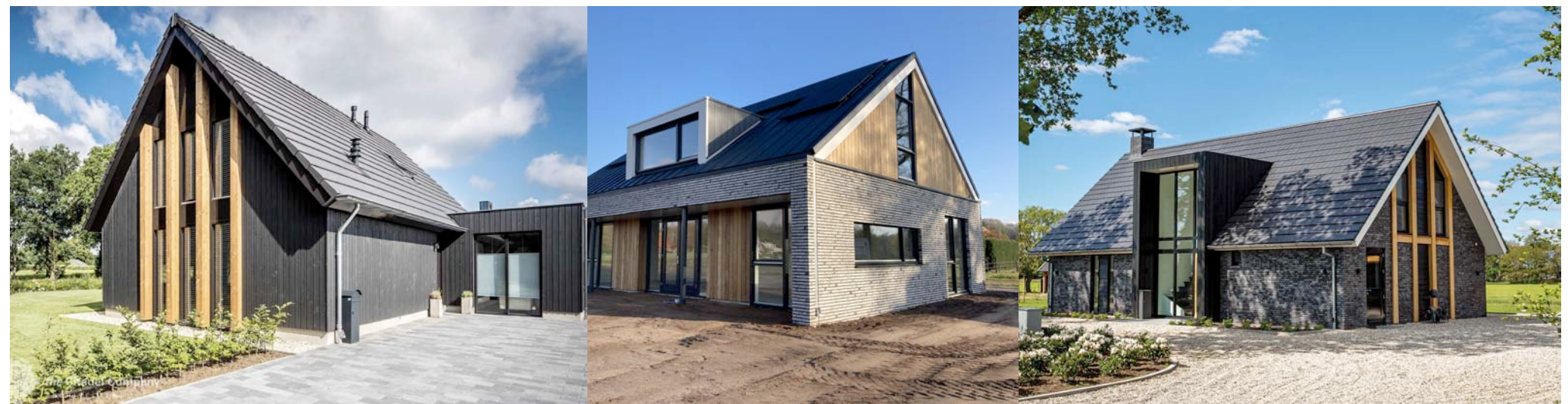
Renovatie aanwezige woningen, transformatie kantoorgebouw, vormgeving nieuwe woningen
