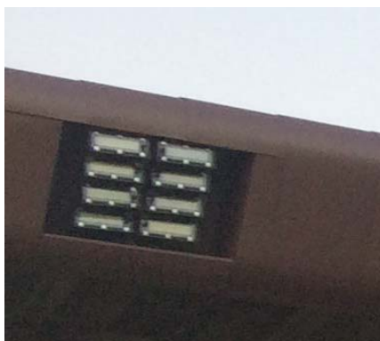
Figuur 2.3: 8 LED lampen per verlichting bundel
