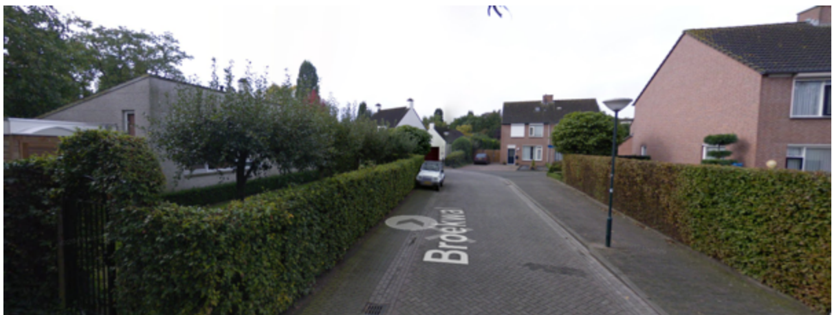
Broekwal gezien vanuit het westen (bron: google.nl)
