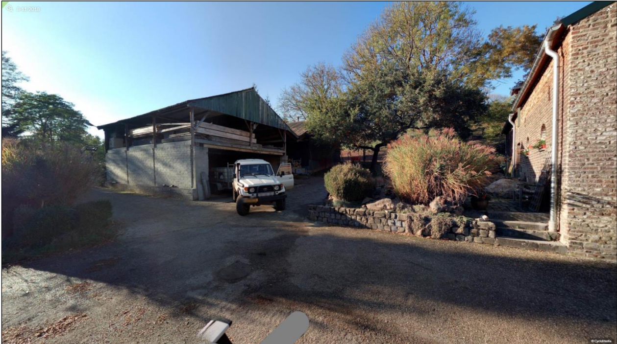
figuur 3: Aanzicht carréboerderij en bestaande schuur (Cyclomedia)
