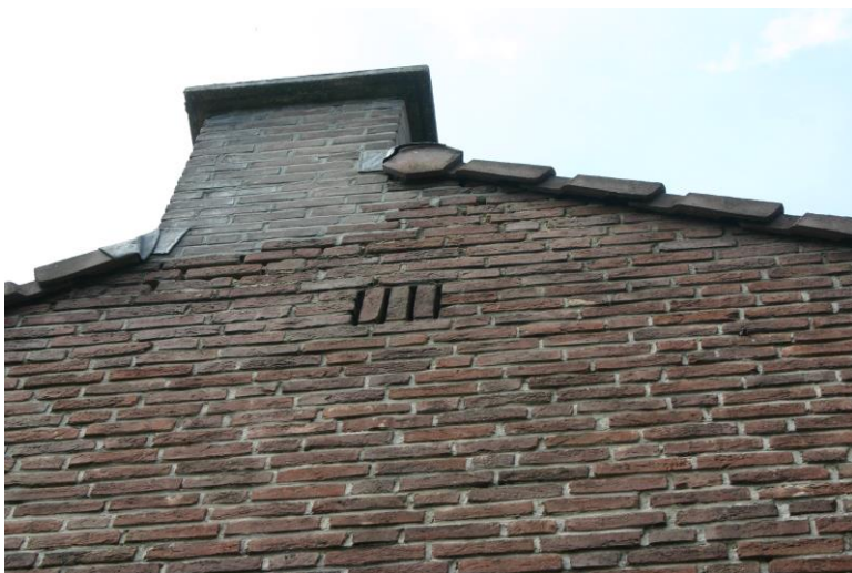
Figuur 4.2.3 De kopwoningen bevatten meerdere ventilatiesleuven op circa 5 meter hoogte.
