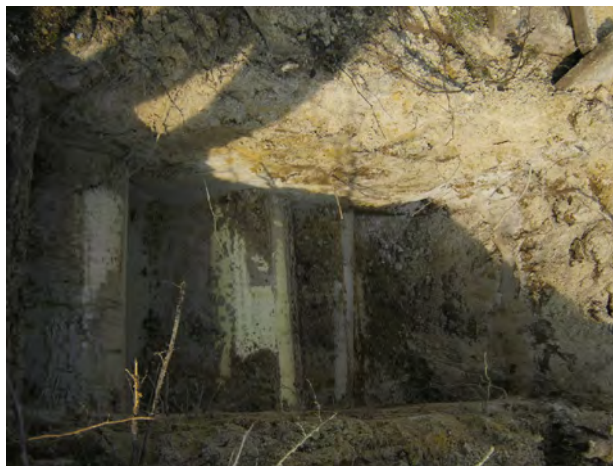
Foto 6: leidingen proefsleuf PS06
