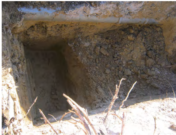
Foto 8: leiding proefsleuf PS07
