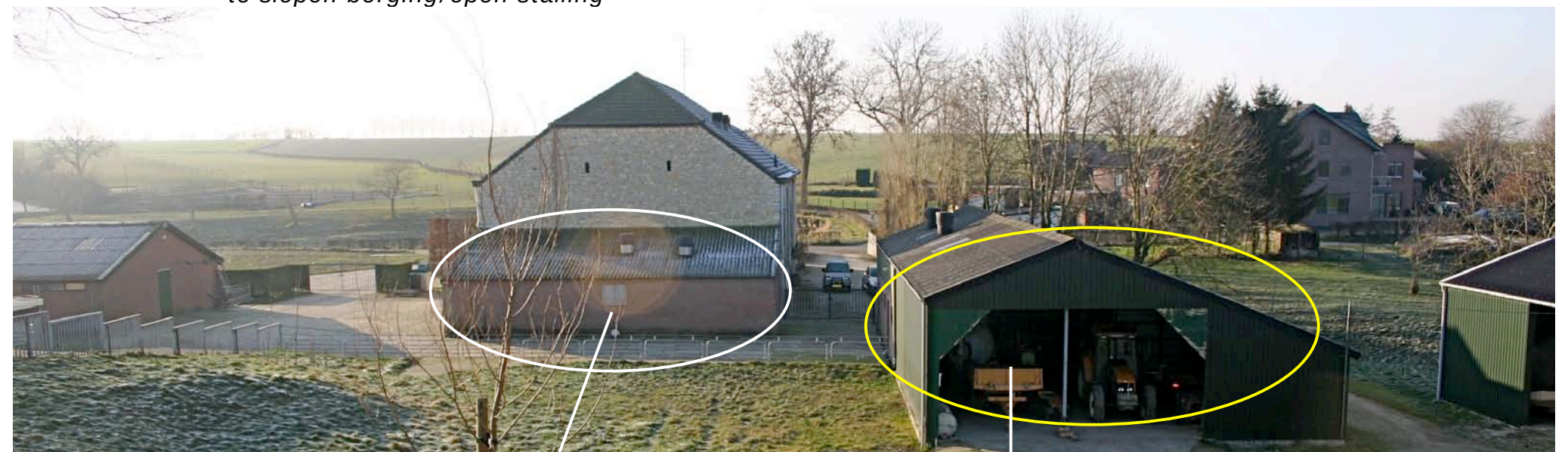
te slopen aanbouw
