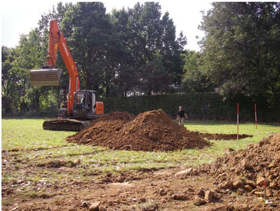
Afbeelding 3: Aanleg van werkput 2
