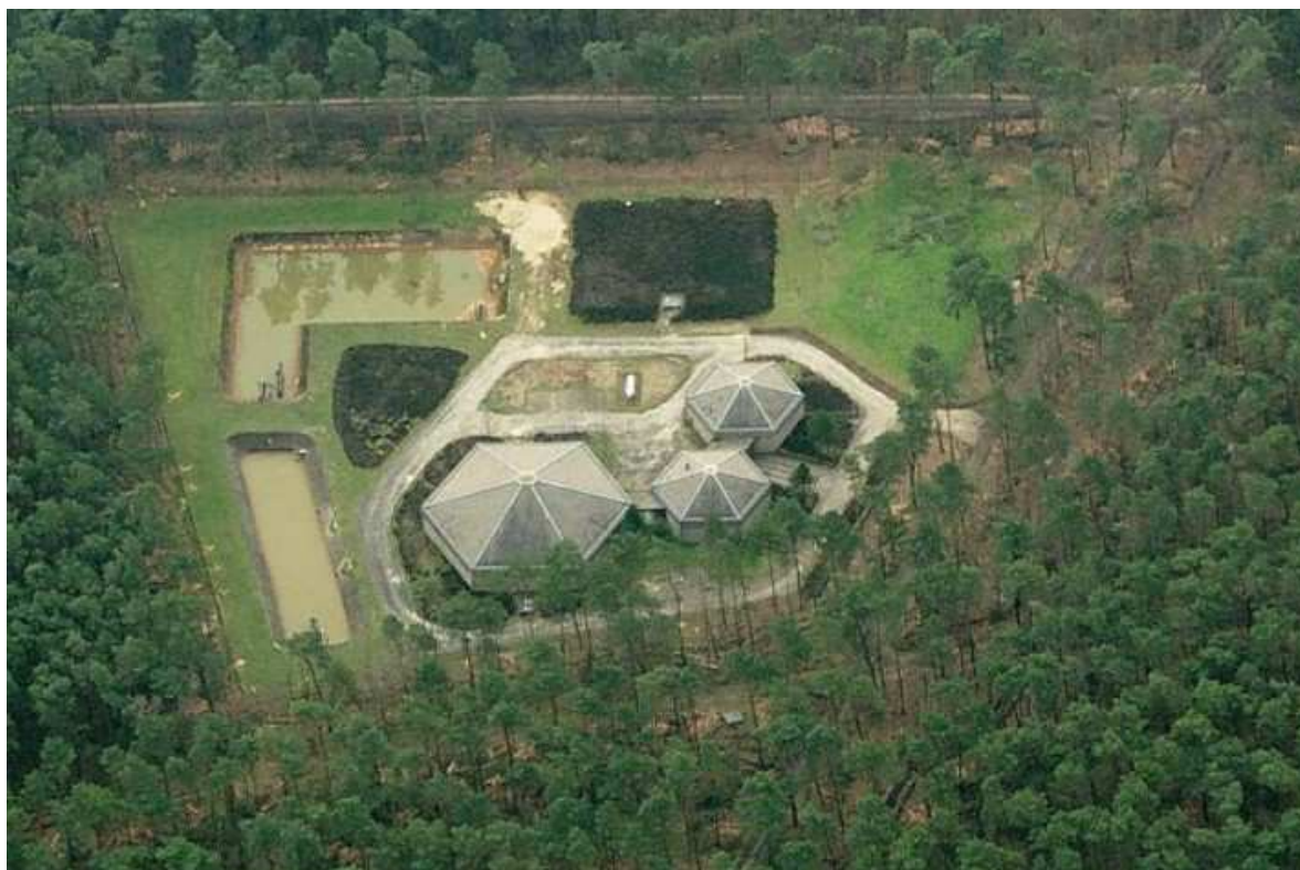
Foto 22. Luchtfoto Bing.Maps, pompstation WML, Heringsweg3 a (aan bovenzijde)
