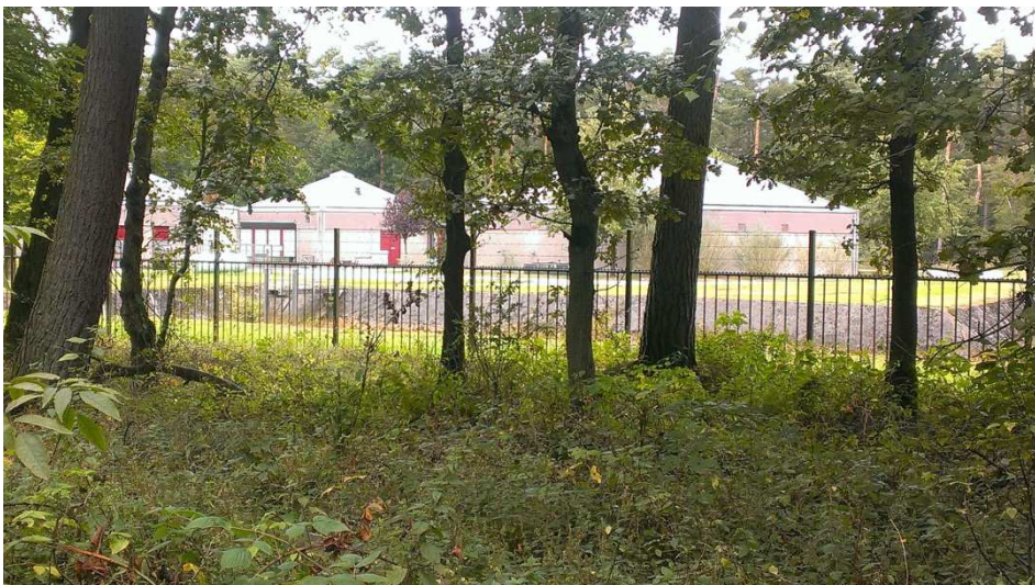
Foto 6. Pompstation WML, Heringsweg 3a
