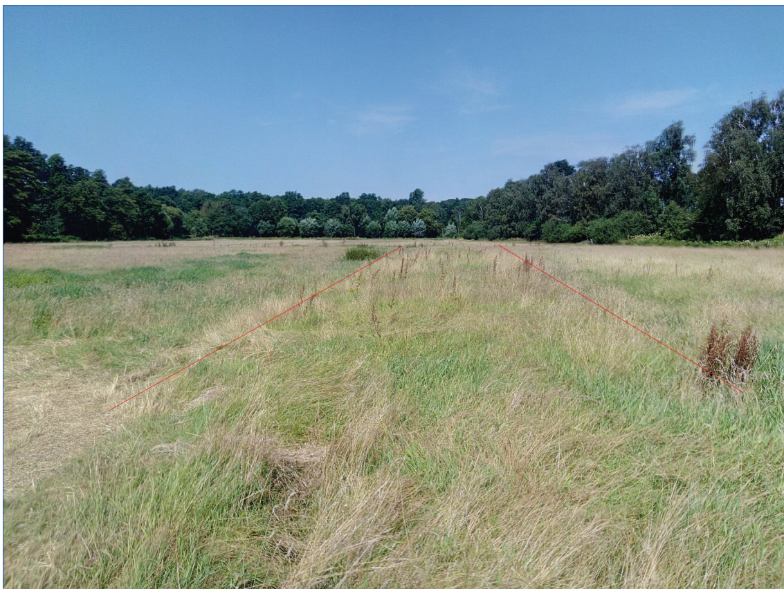
Figuur 26. Lineair pakket leem, aangebracht ter ontsluiting van de hooilanden.
