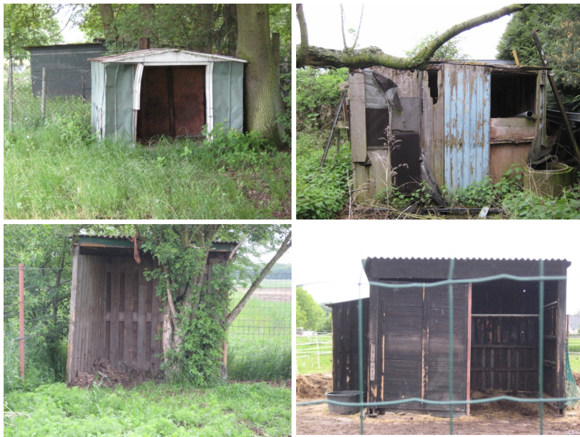
Figuur 5-1 In bovenstaande afbeeldingen staan een aantal van de te slopen opstallen weergegeven. Foto's RHDHV, 2013
