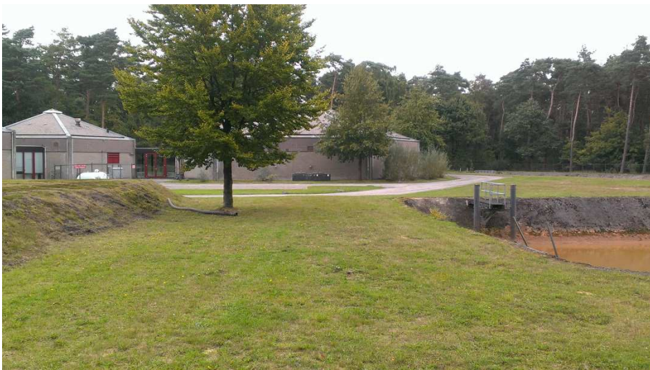
Foto 8. Pompstation WML (rechts spoelvijver, achtergrond pompgebouw), Heringsweg 3a
