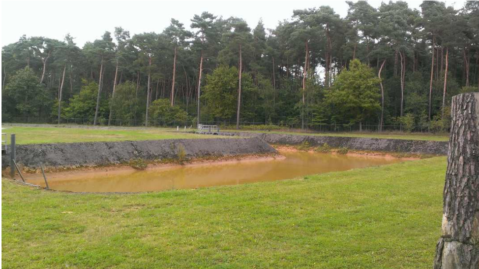
Foto 7. Pompstation WML (spoelvijver), Heringsweg 3a
