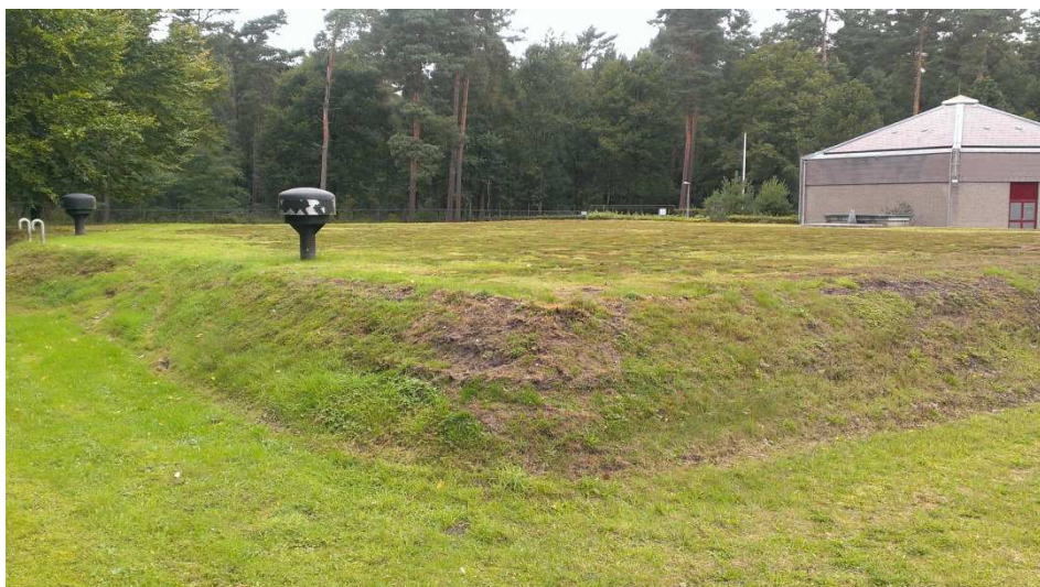
Foto 10. Pompstation WML, Heringsweg 3a
