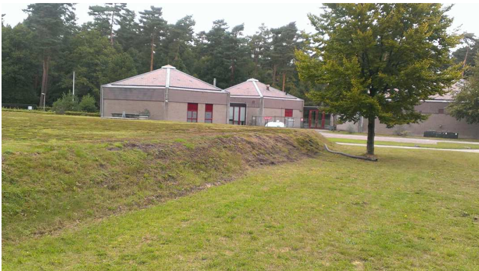
Foto 9. Pompstation WML, Heringsweg 3a
