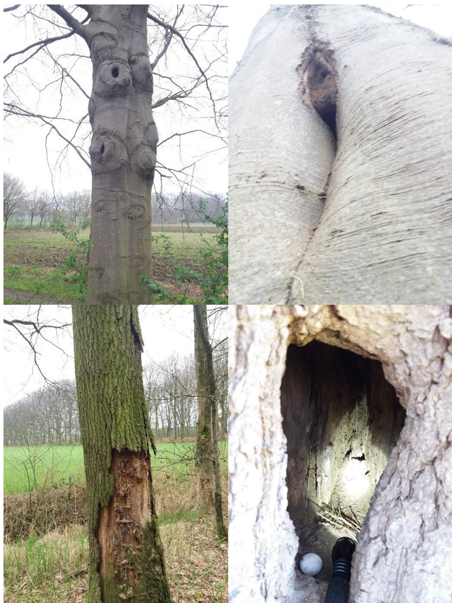
Figuur 5-1. Potentiële verblijfplaatsen voor vleermuizen. Op de foto rechtsonder is een ei aangetroffen in een boomholte. Deze holte liep in de boom ver door omhoog waardoor niet de totale holte bekeken kon worden met de endoscoop.
